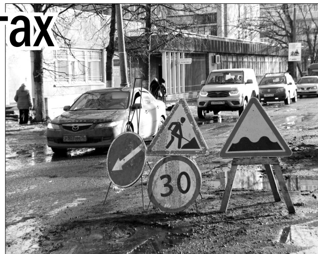
Ремонт на улице Чехова.
