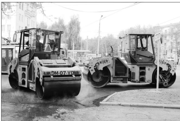
Сначала люки закатываются асфальтом, а потом поднимаются специальной фрезой.
