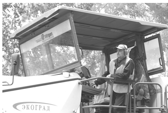
Дорожной фрезой снимают верхний слой асфальта.
