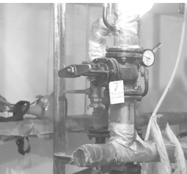
В подвале дома.
