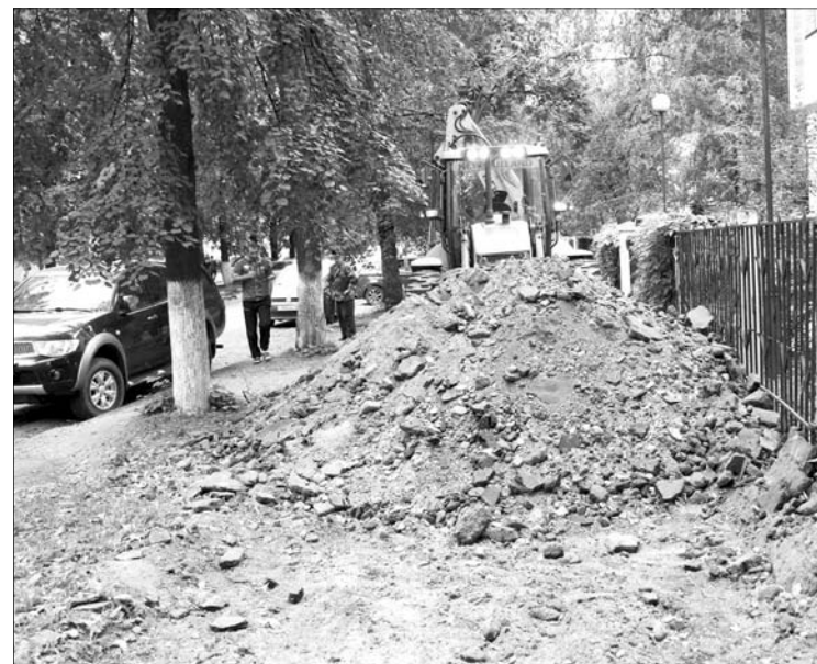
Улица Терешковой. Работы ведет Угличское ДСУ. Здесь монтируют бортовой камень, обустривают тротуары, укладывают выравнивающий слой асфальтобетонного покрытия. Завершение основных работ – 1 сентября.
