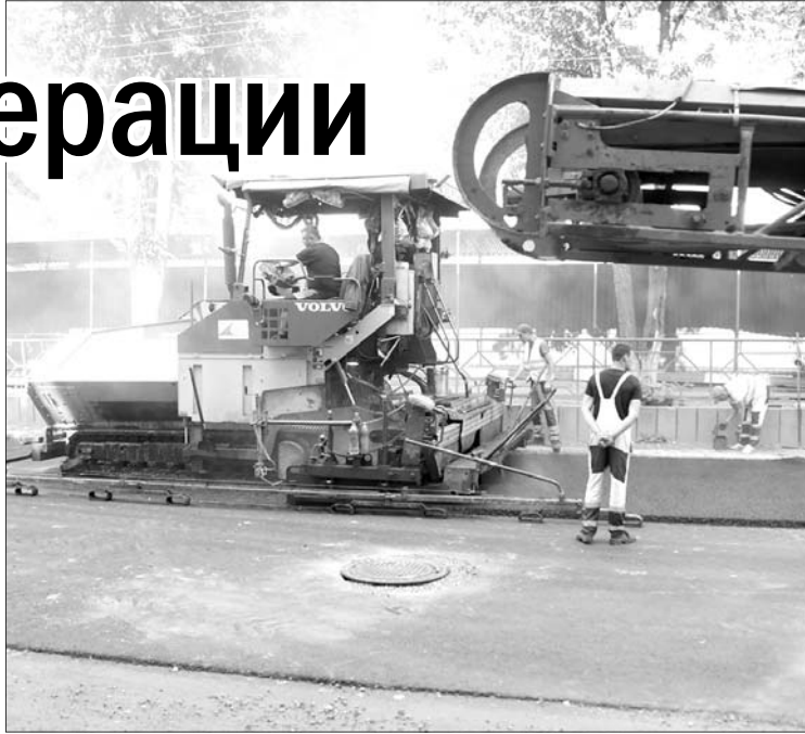
Улица Свердлова. Работы ведет ООО «Дорожное управление», г. Вологда. После укладки асфальта рабочие приступят к нанесению разметки, обустройству искусственных неровностей, установке дорожных знаков. Подрядчик завершит все работы в сентябре.
