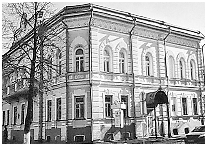
Дом Кузнецова на Волжской набережной в Ярославле.
