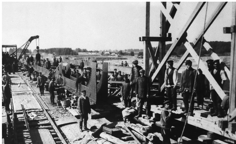
Строительство моста. 1911 г.
