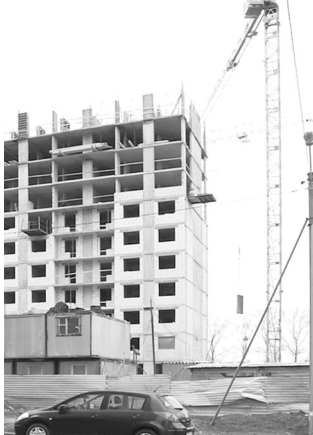
Строящийся дом в микрорайоне «Яблоневый посад».
