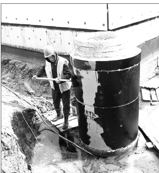
Гидроизоляция дренажного колодца на улице Академика Колмогорова.
