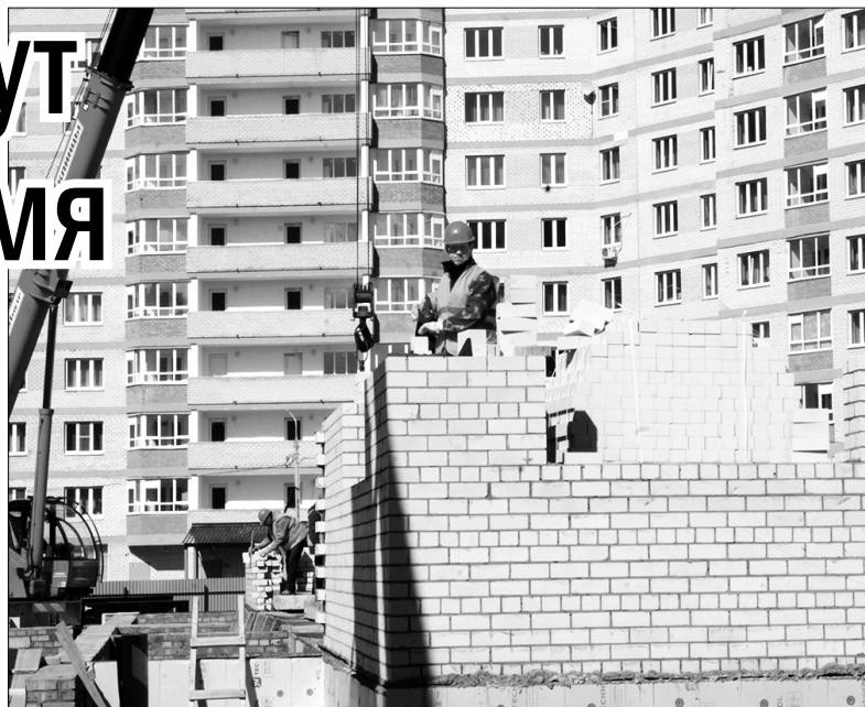
Возведение 1-го этажа детсада на улице Чернопрудной.
