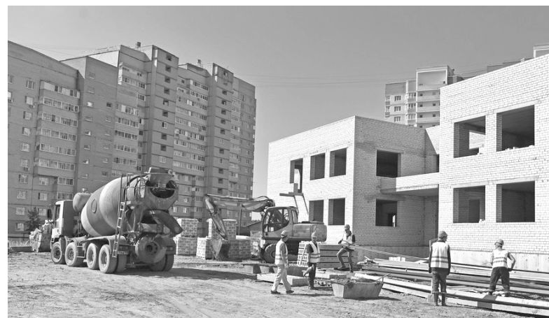
Строительство детского сада на улице Чернопрудной.
