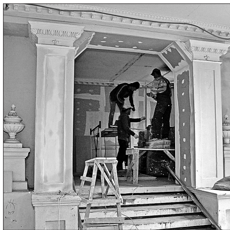
Ремонт близится к завершению.
