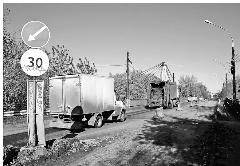
Мост через Которосль.
