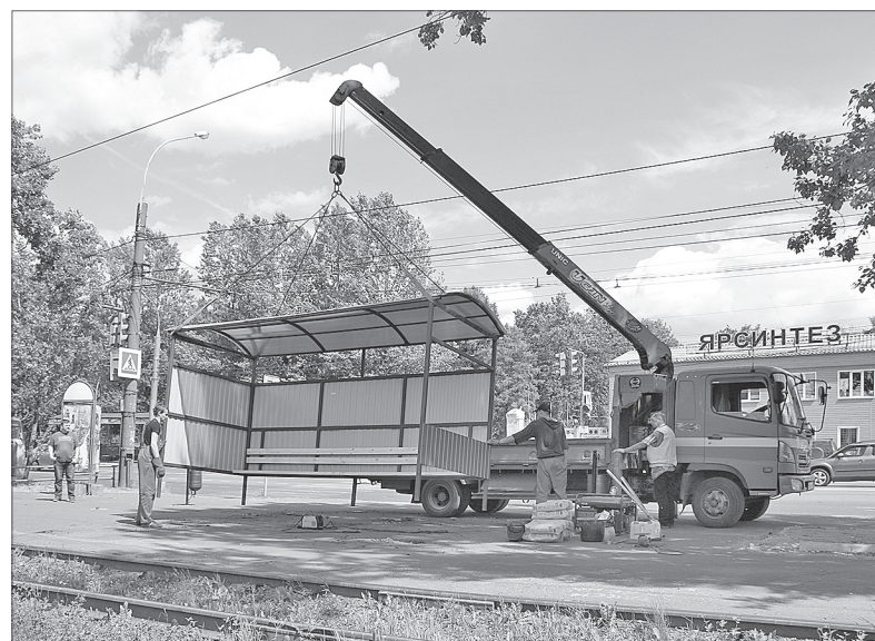
Установка нового НТО.
