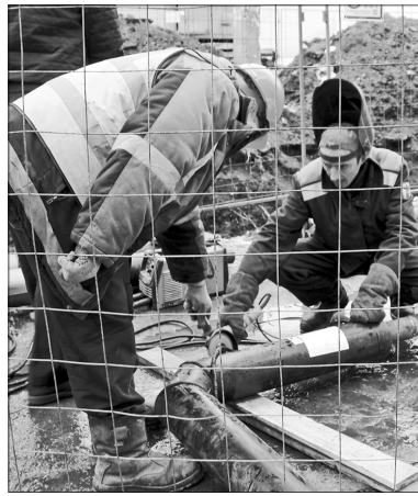
Полный ремонт участка сетей.
