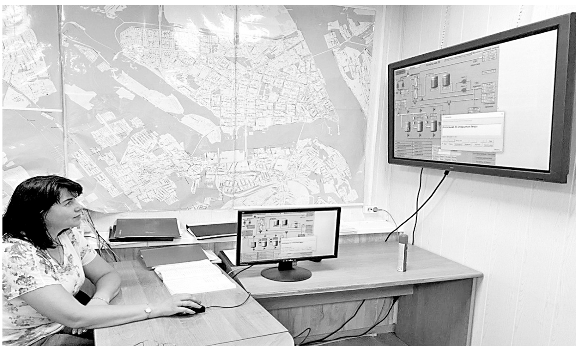
К системе диспетчеризации АО «Яргортеплоэнерго» подключены все котельные, и информацию по каждой из них можно посмотреть в отдельности.
