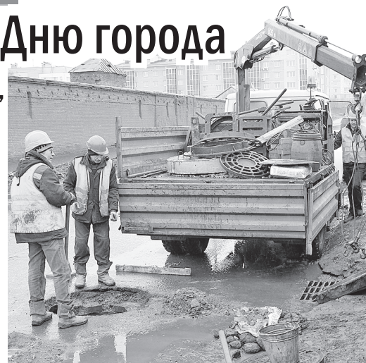
Ремонт люка на Б. Павловской.
