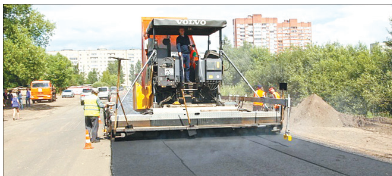
Рабочие укладывают выравнивающий слой асфальта.
