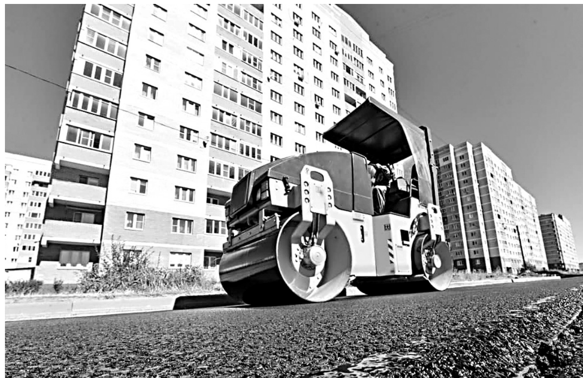
Работы по БКД идут во всех районах города.
