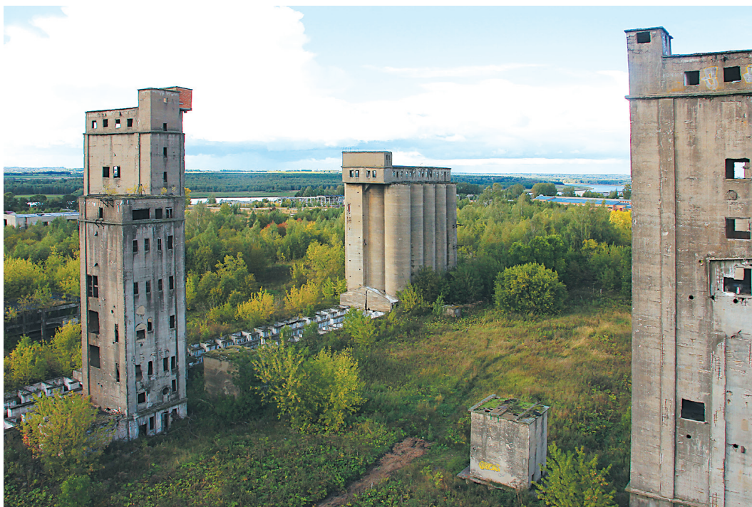
↓ Хлебобазы № 61 разрушается с 1990 года.
